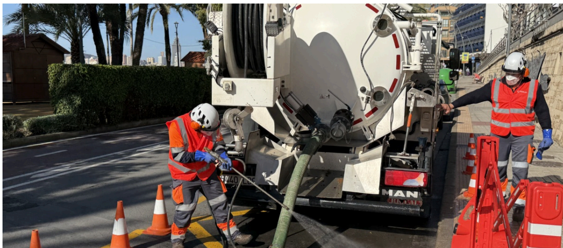
Imagen de unos trabajos de revisión del alcantarillado en BenidormEl Debate
